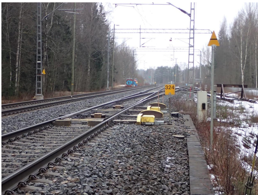
Kuva 3. Vaihte V324 sijaitsee noin kaksi kilometriä Hyvinkään aseman pohjoispuolella. Vaihte on käännetty sivulle johtavaan asentoon kuten vaaratilanteen tapahtuessa.
