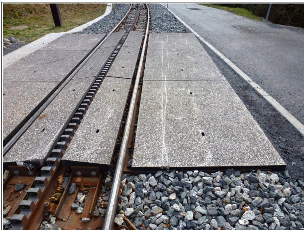
Figure 12 : Vue du platelage du passage à niveau des Muletiers
