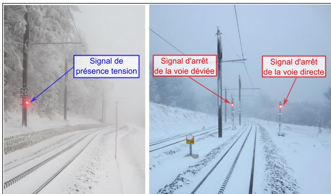
Figure 11 : Signal de « présence tension » et signaux d'arrêt en place avant le 25 octobre 2012
