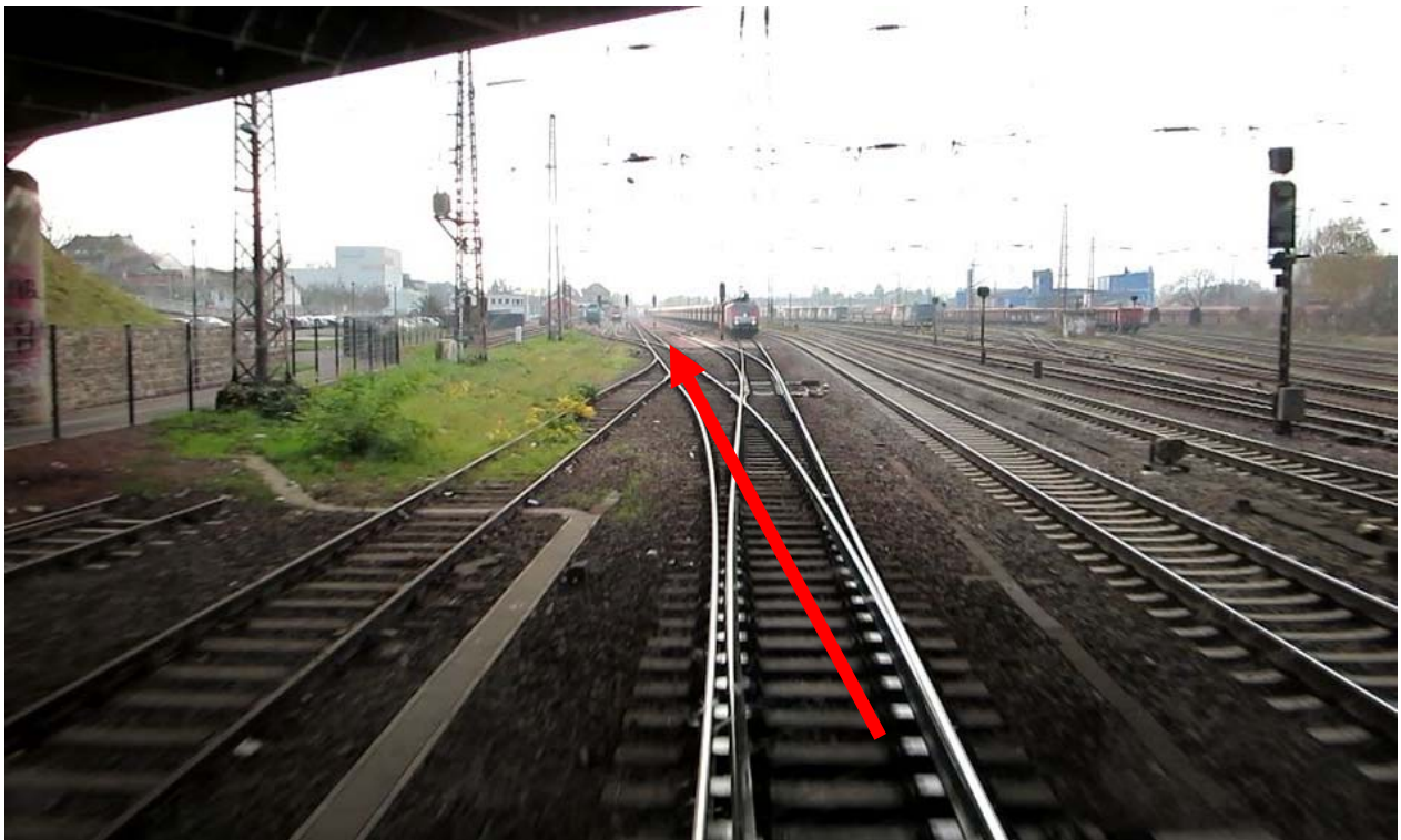
Abb. 3 Einfahrt Dillingen; Gleis 1 aus der Sicht des Tf RB 13765 ab Industriebrücke
