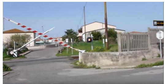
Figura 31 –Barriere in fase di movimentazione
