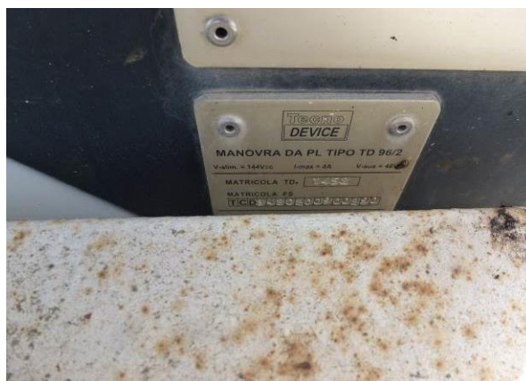
Figura 7 - Dati di Targa delle casse di manovra delle barriere del PL 140+487
