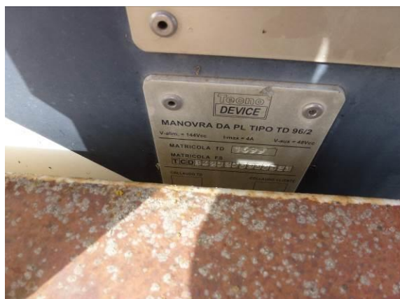
Figura 7 - Dati di Targa delle casse di manovra delle barriere del PL 140+487
