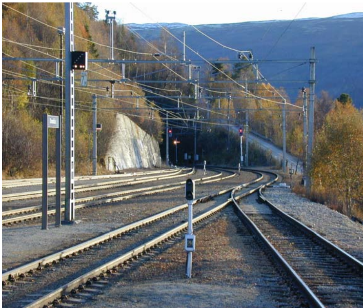
Sporarrangementet i sydenden av Dombås stasjon. Signallyset i tunnelåpningen er middelkontrollampen.
