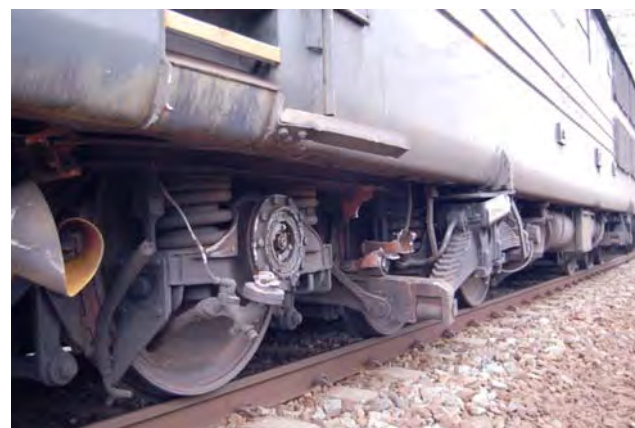
Figur 4: Skader på boggi og fjæroppheng på lokomotivet i tog 5722
