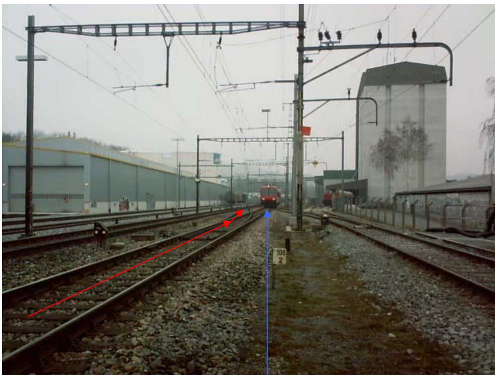
Der rote Pfeil bezeichnet die eingestellte Fahrstrasse für Zug 516 von Gleis 203 nach Gleis 3. Im Vordergrund die Weiche 5.
