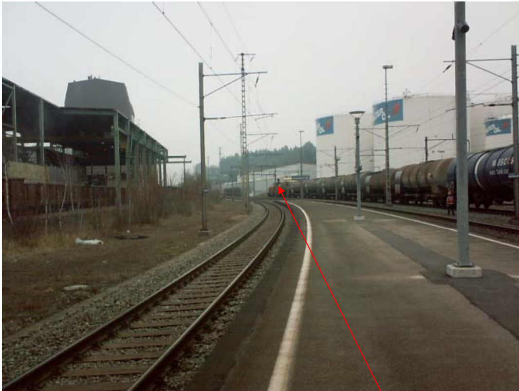
Blick vom Halteort Regionalzüge gegen das Ausfahrtsignal B4. Standort Fahrtstellungsmelder
