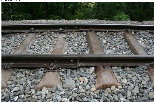
Verschweisster Uebergang Schienentyp SBB 1 (links) zum Schienenprofil VST (rechts).
