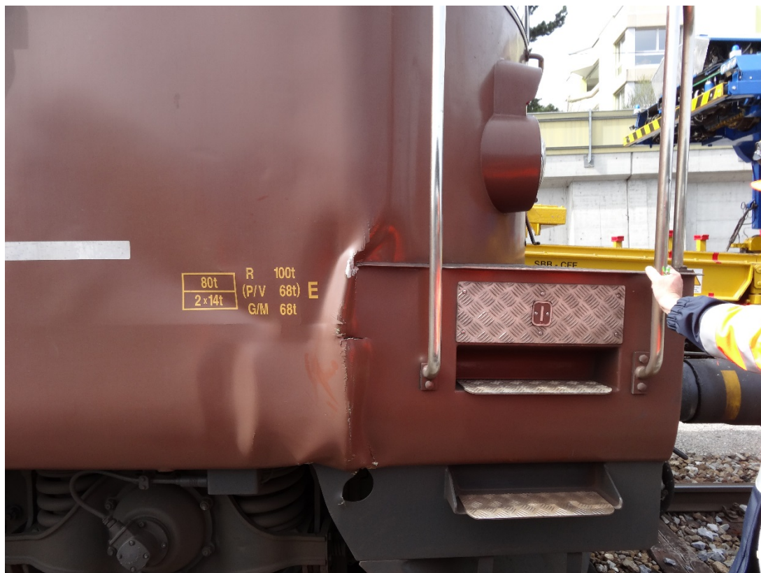
Foto 2: Gestauchter Kasten der Lok Re 425 191 (Quelle: SUST).
