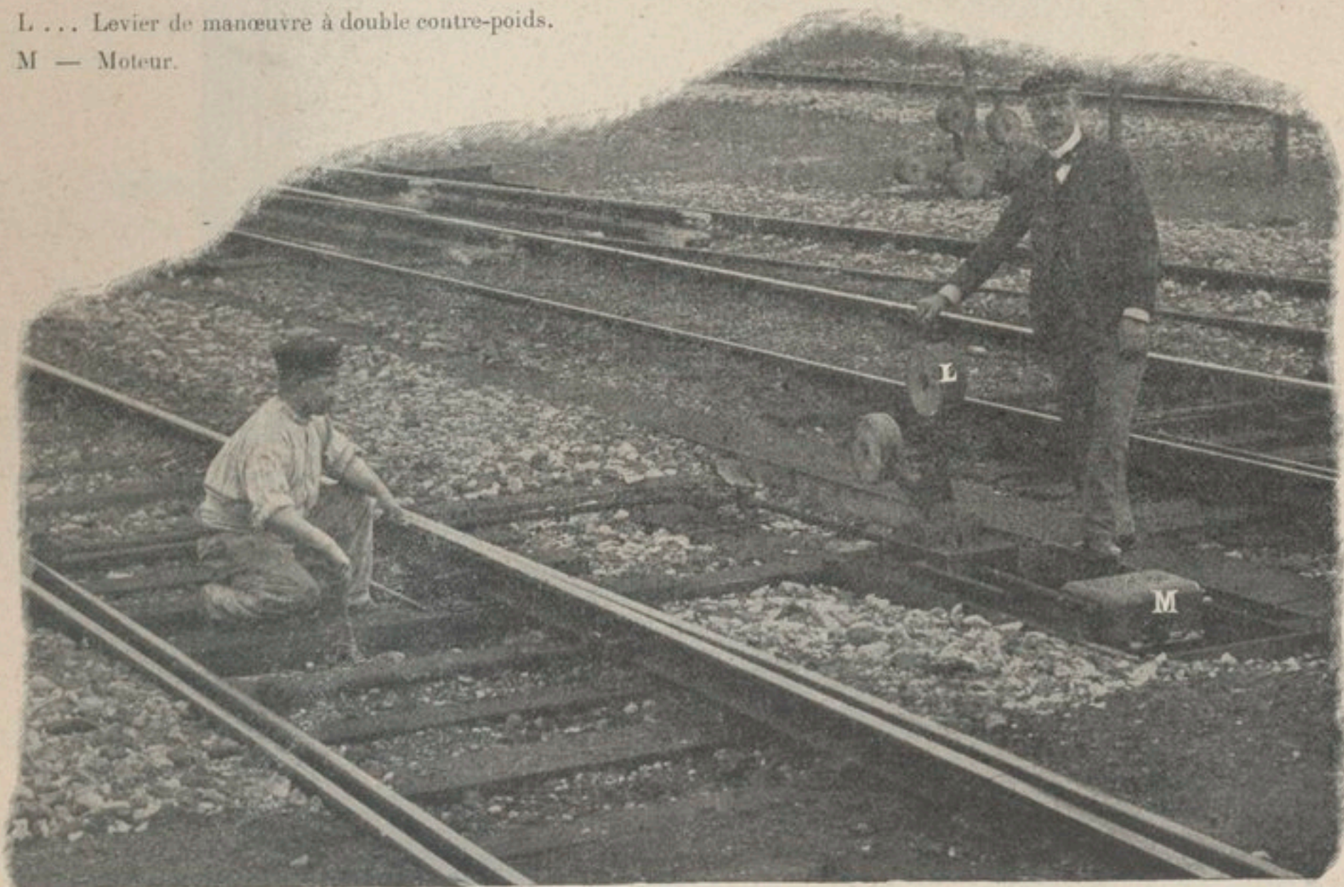
Fig. 26. — AIGUILLE MANŒVRABLE A DISTANCE OU A PIED D'ŒUVRE.
