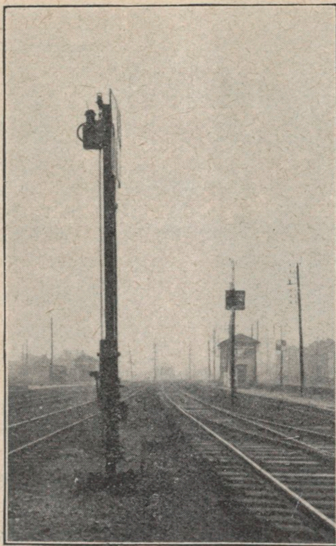
Fig. 34. — SIGNAL CARRÉ EN POSITION DE VOIE LIBRE.
