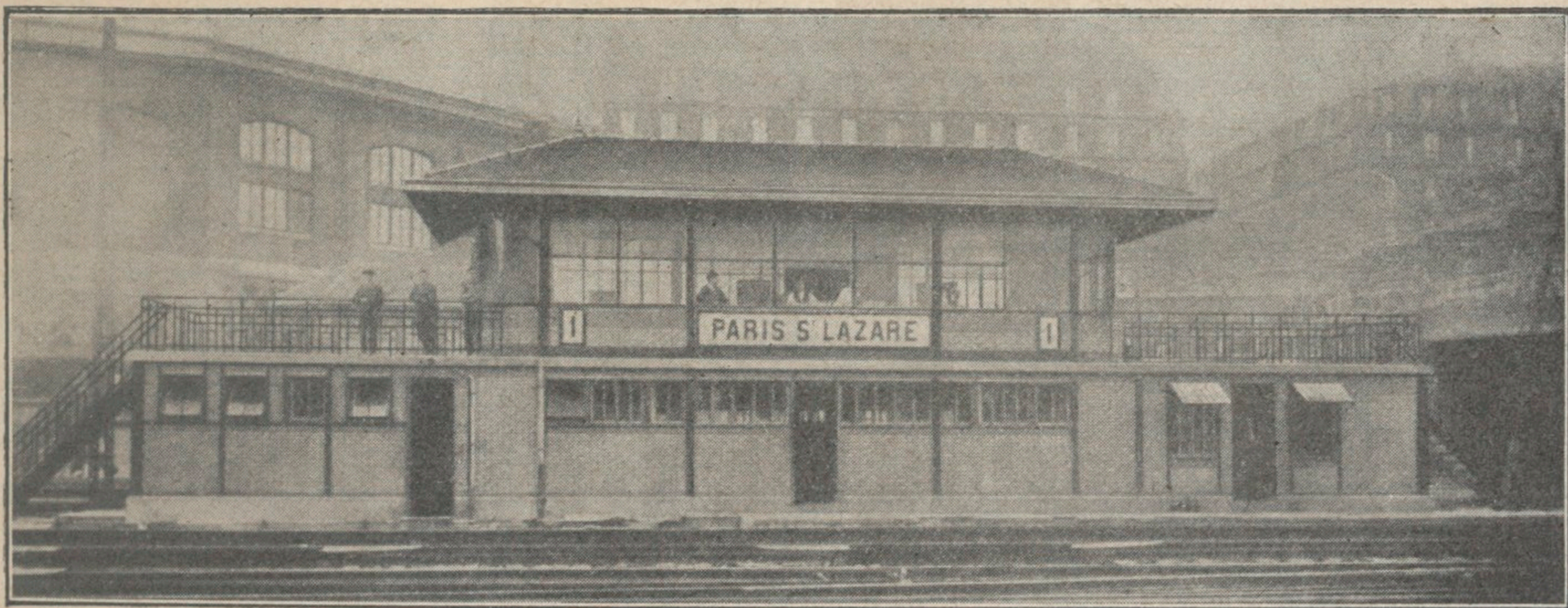
Fig. 1. — NOUVEAU POSTE ÉLECTRO-DYNAMIQUE.
